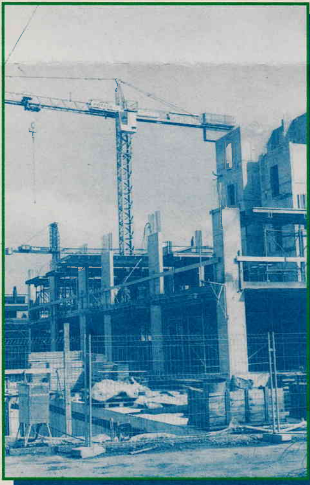
Die Bautätigkeit im Industriegebiet Forren West
